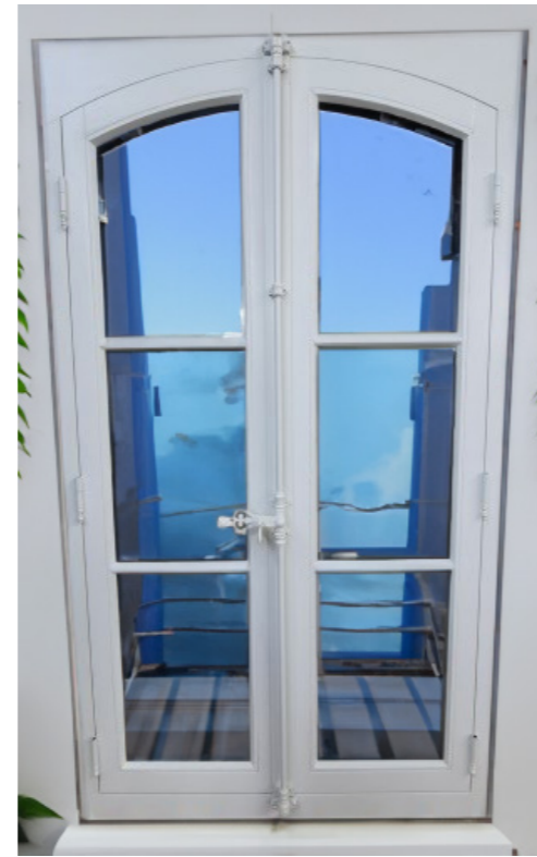
Fenêtre GDL à rive droite
